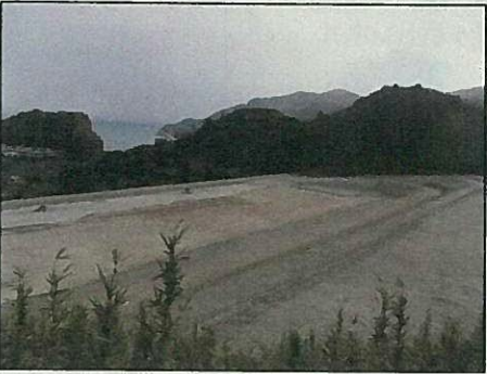
盛土造成箇所（西側より）
