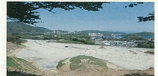
盛土造成箇所 (上部より)
