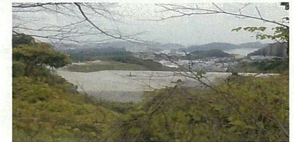
盛土造成箇所（上部より）
