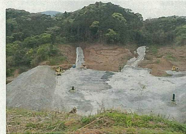
南側仮設沈砂池
